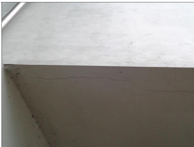
26 Trhliny v podhledu NK v poli 1 vlevo.JPG
