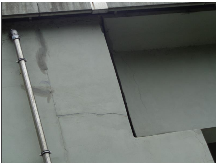
28 Trhliny v uloznem prahu P2 vpravo.JPG
