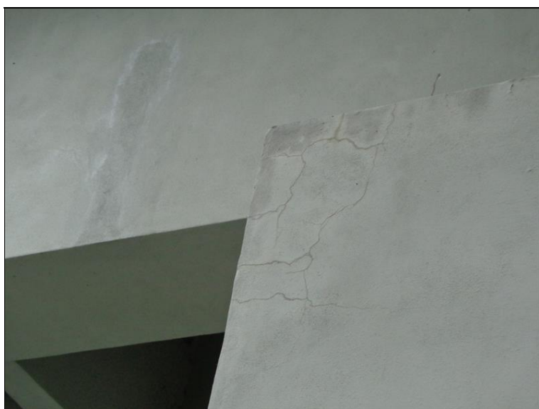
27 Trhliny v uloznem prahu P2 vlevo.JPG
